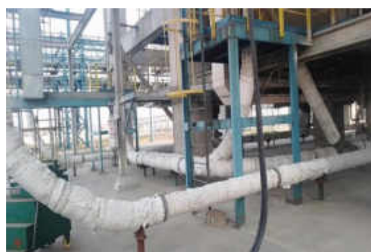
聚丙烯装置掺混料仓输送管线加装隔音棉
