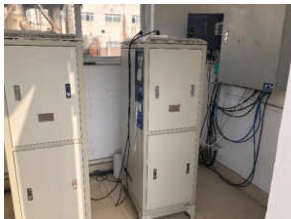
接管口在线 COD、氨氮在线监测仪
