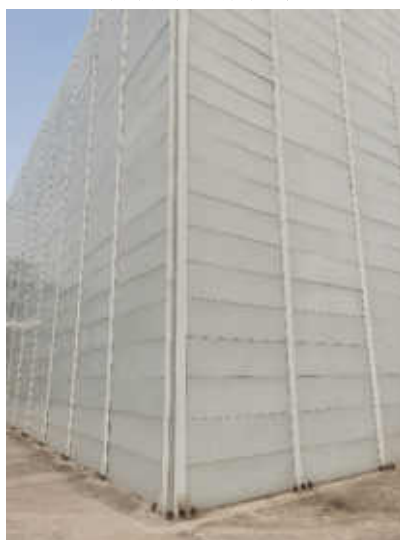
空分分馏塔隔声装置
