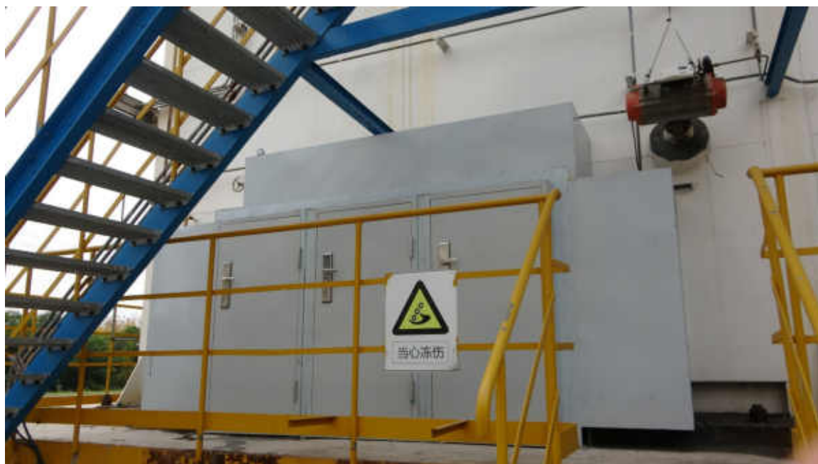
空分分馏塔隔声装置
